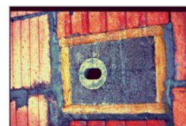
▲ zur Verhinderung von Kältebrücken (Isolierung bauseits)
