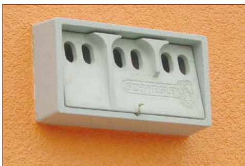
▲ Sperlingskoloniehaus in der Dämmung eingelassen
